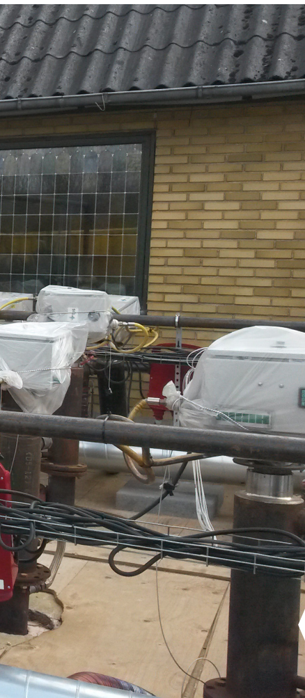
40 stålrør boret ned i 12 meters dybde skulle der til for at oprense de i alt 1.650 ton olieforurenede jord. Læg mærke til de skråtstillede rør ved husmuren. Med disse oprenses også forureningen under villaen.
